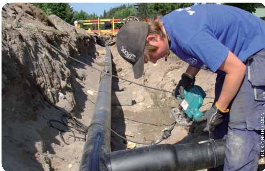
Kulvertarbete vid fjärrvärmesystemutbyggnad på Storstrand.
